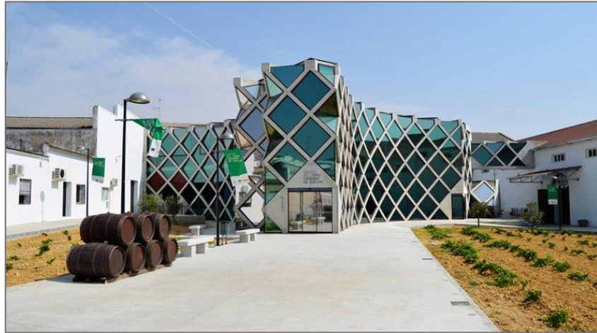
Imagen N° 11: Fotografía de la Fachada del edificio
