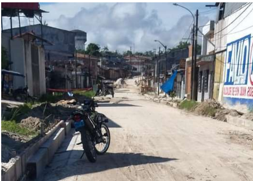
Foto 2: Bultos de arena a lo largo del tramo
