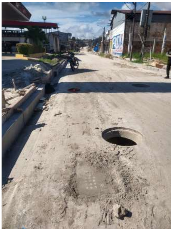
Foto 1: Humedad al limpiar el espacio de ensayo
