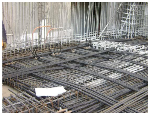
Imagen N° 11: Cables con sistema de adherencia
