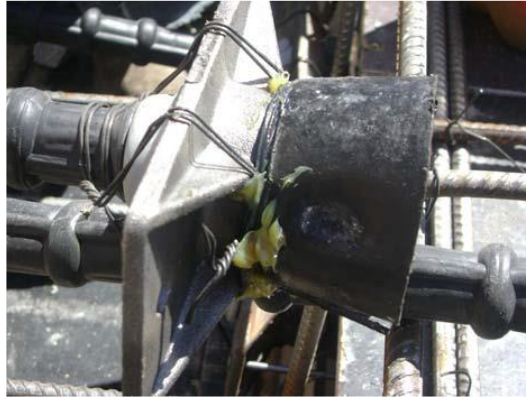
Imagen N° 12 : Anclaje activo (Gatica Bertin , 2009)
