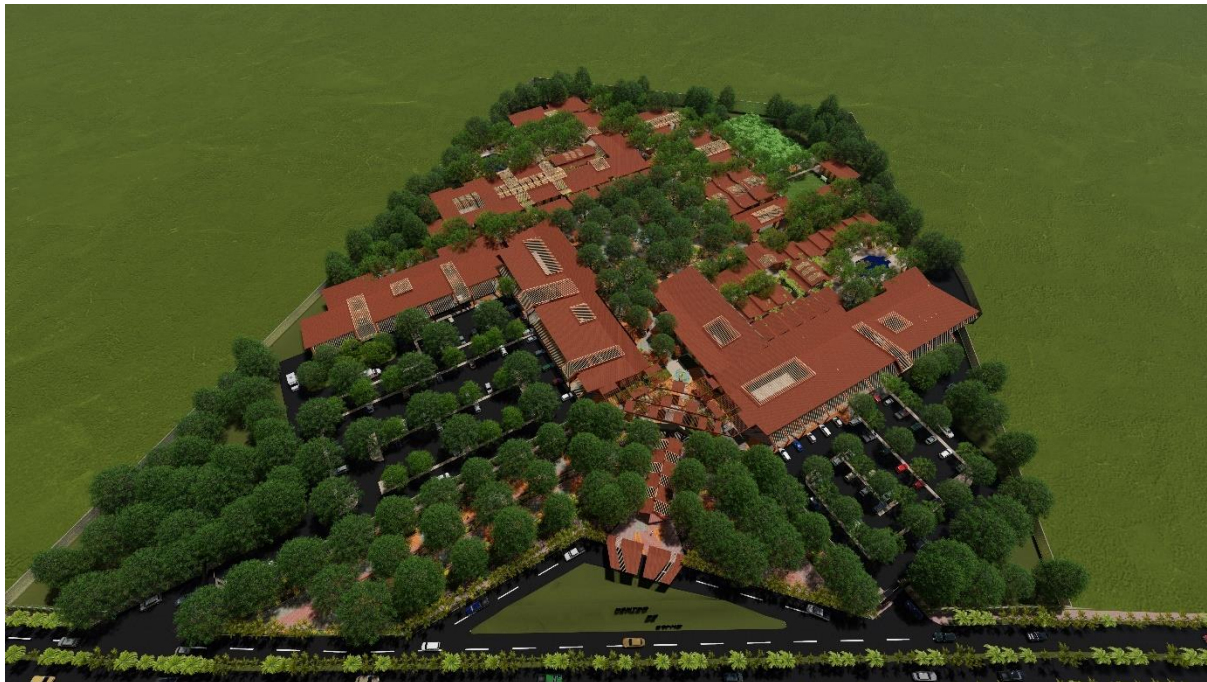
Figura 21. Vista aérea - conjunto
