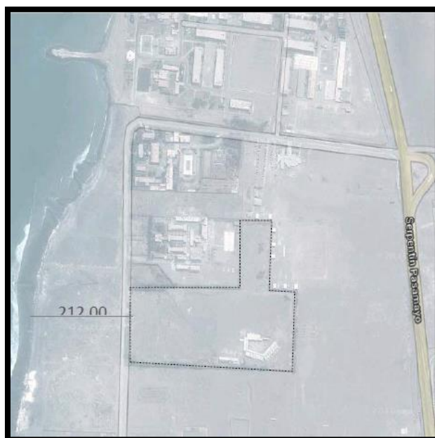
Figura 112. Vista aérea de la ubicación del terreno.
