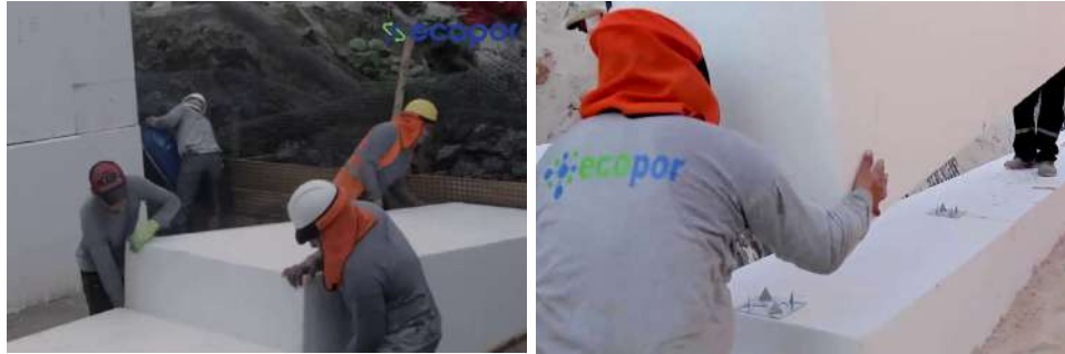
Figura 13. Colocación de Geoespuma
