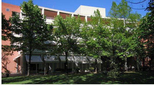
IMAGEN 03: USO DE LA VEGETACIÓN EN EDIFICIOS
