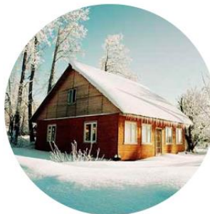
IMAGEN 10: Vivienda frente a bajas temperaturas
