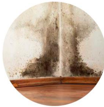
IMAGEN 13: Protección contra la humedad ambiental.
