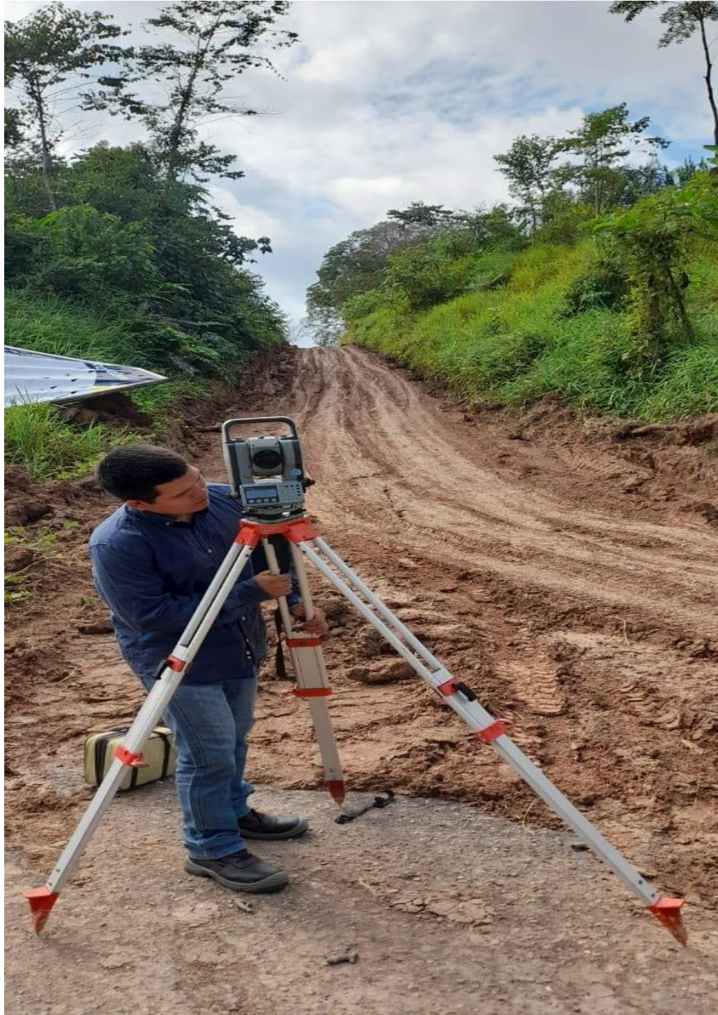
imagen 8 : LEVANTAMIENTO TOPOGRÁFICO DE LA CARRETERA DE CONTAMANA - CENTRO POBLADO RURAL SAN SALVADOR, PROVINCIA DE UCAYALI – LORETO.
