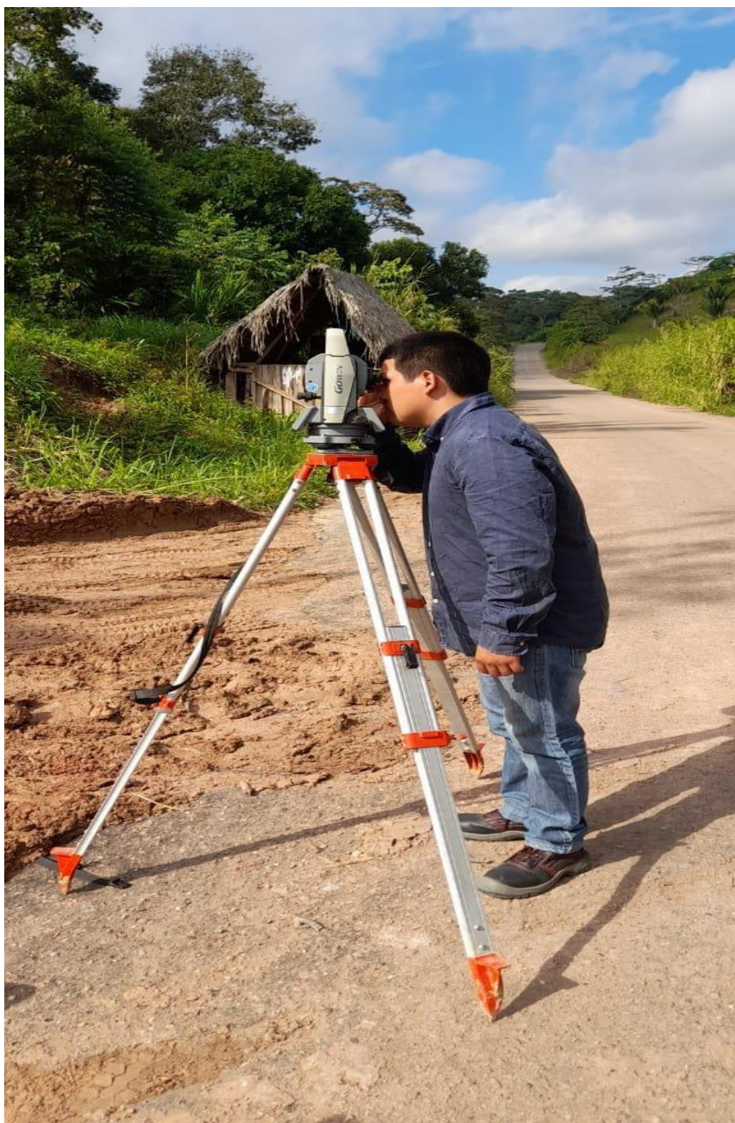
imagen 9 : LEVANTAMIENTO TOPOGRÁFICO DE LA CARRETERA DE CONTAMANA - CENTRO POBLADO RURAL SAN SALVADOR, PROVINCIA DE UCAYALI – LORETO.
