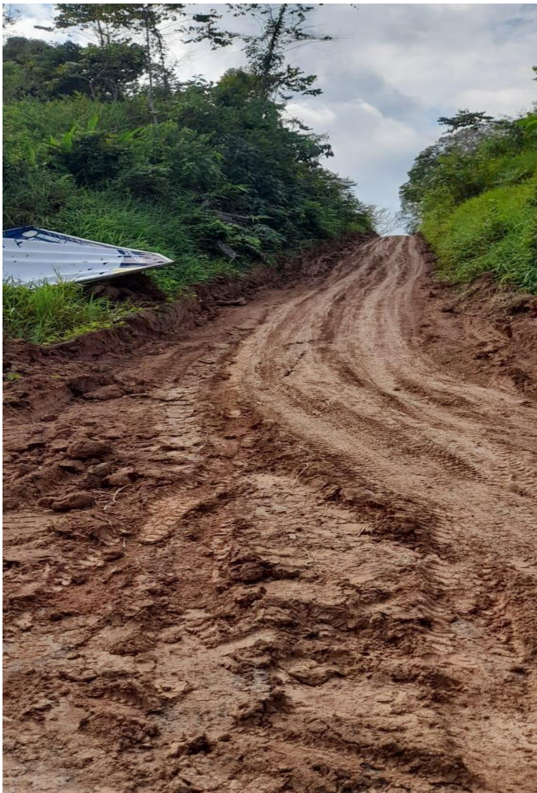
imagen 10 :LEVANTAMIENTO TOPOGRÁFICO DE LA CARRETERA DE CONTAMANA - CENTRO POBLADO RURAL SAN SALVADOR, PROVINCIA DE UCAYALI – LORETO.
