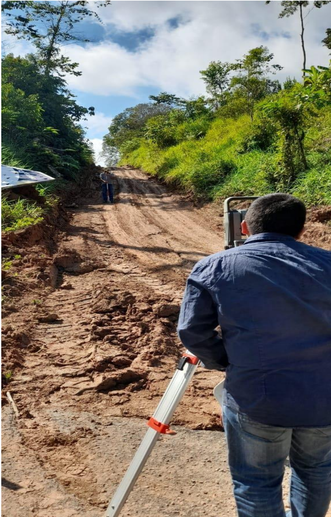
imagen 12: LEVANTAMIENTO TOPOGRÁFICO DE LA CARRETERA DE CONTAMANA - CENTRO POBLADO RURAL SAN SALVADOR, PROVINCIA DE UCAYALI – LORETO.
