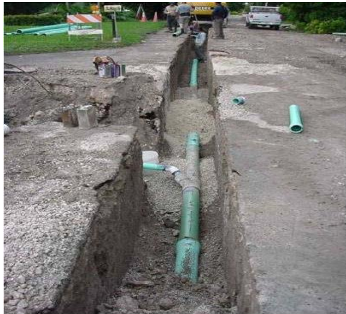
FIGURA N° 05: TRAZADO EXCAVACIÓN RED DE VACÍO 17 .
