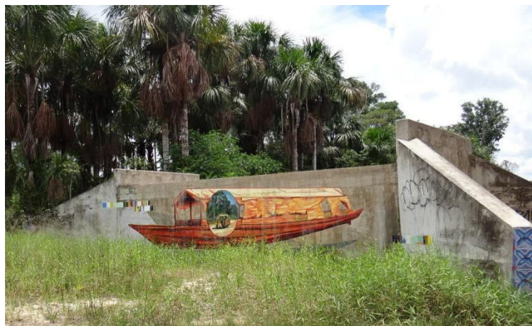
Puente de la carretera Zungarococha
