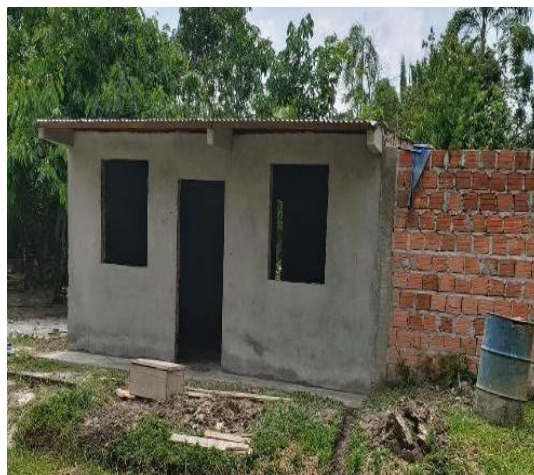
Viviendas con porcentaje mínimo de pendiente en techos.
