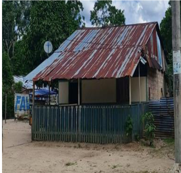
Vivienda de mampostería con techos de calamina
