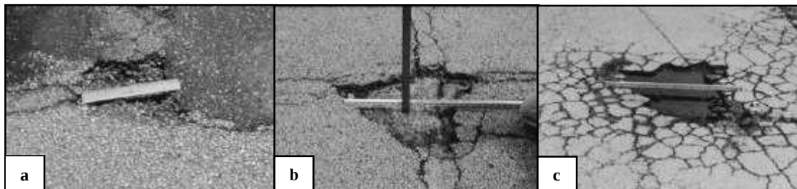
Baches de niveles de severidad bajo (a), medio (b) y alto (c).
