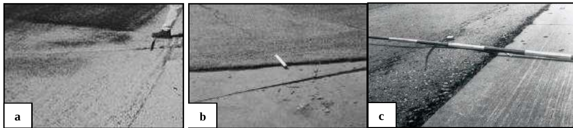
Desplazamiento de nivel de severidad bajo (a), medio (b) y alto (c).
