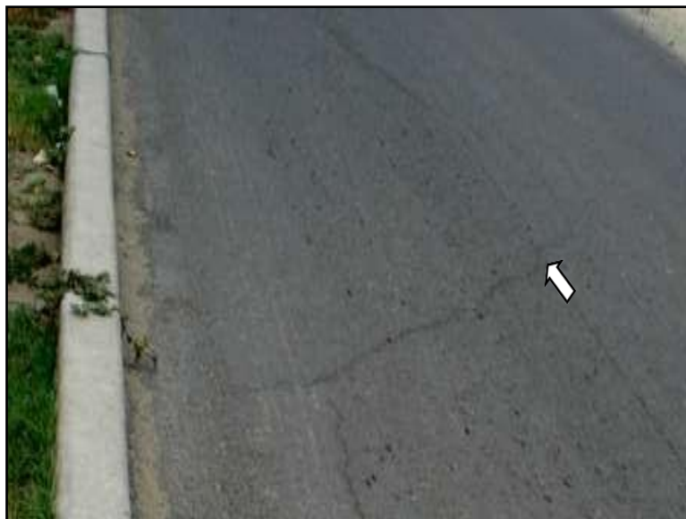
Figura 22. Fisura parabólica.
