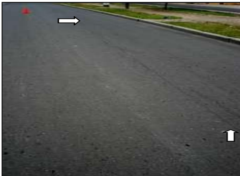
Figura 20. Ahuellamiento.
