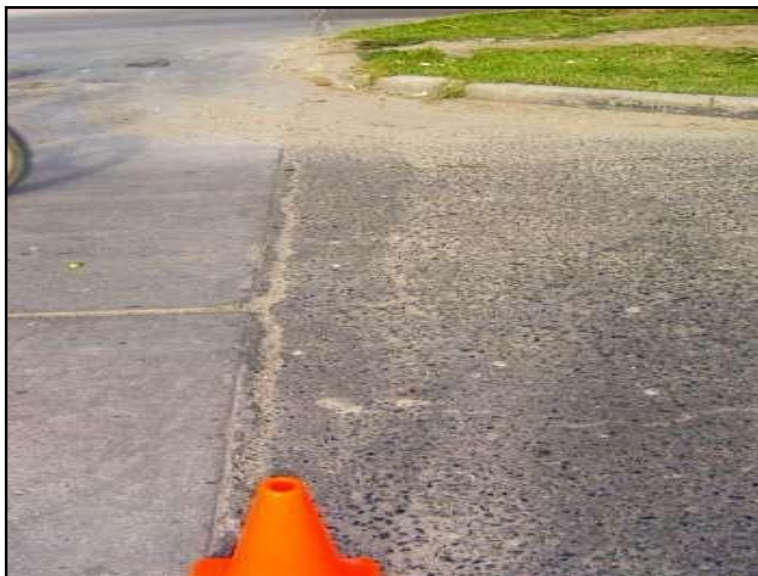
Figura 21. Desplazamiento.
