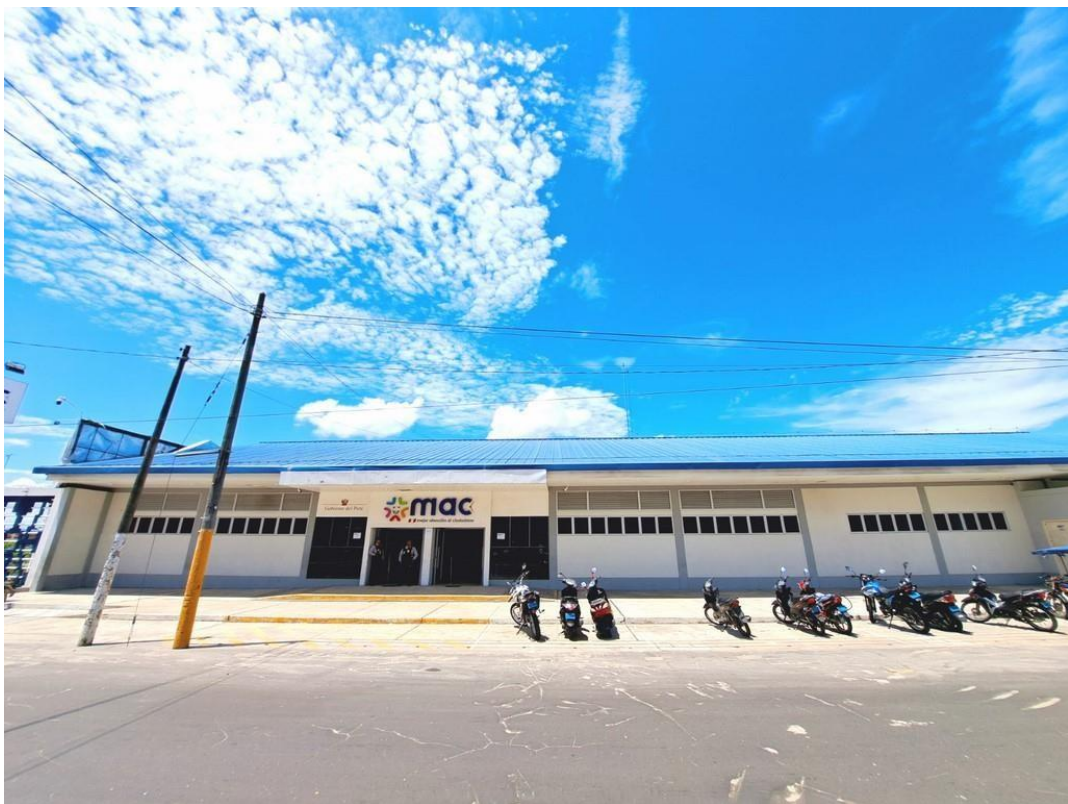
Figura 2 Edificio de las instalaciones del MAC Iquitos, 2022
