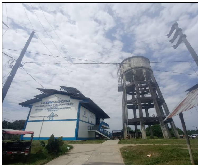
Imagen N° 22: Planta de Tratamiento De Agua
