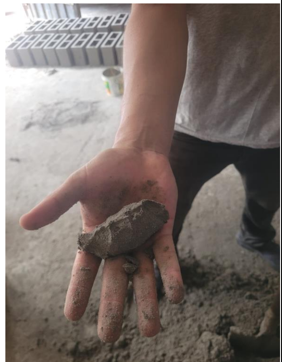
Foto N°24: verificación de la humedad de la mezcla
