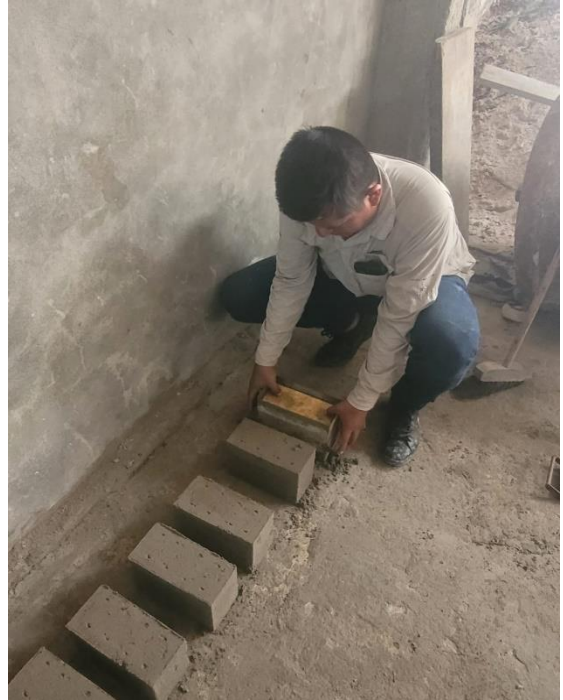
Foto N°26: Proceso de elaboración de las unidades de albañilería
