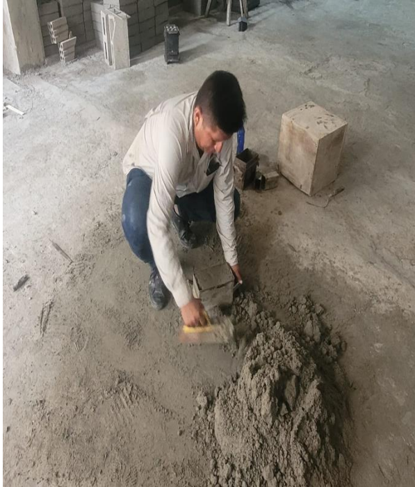
Foto N°25: Proceso de elaboración de las unidades de albañilería
