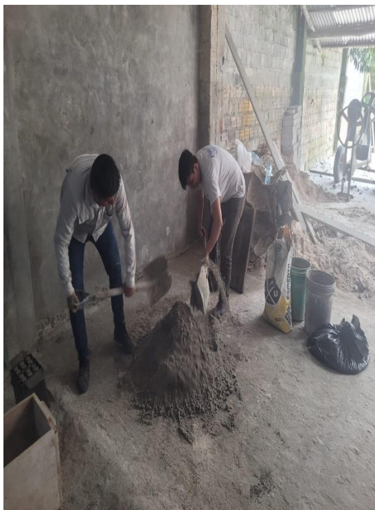
Foto N°23: Preparación de la mezcla para la elaboración del ladrillo
