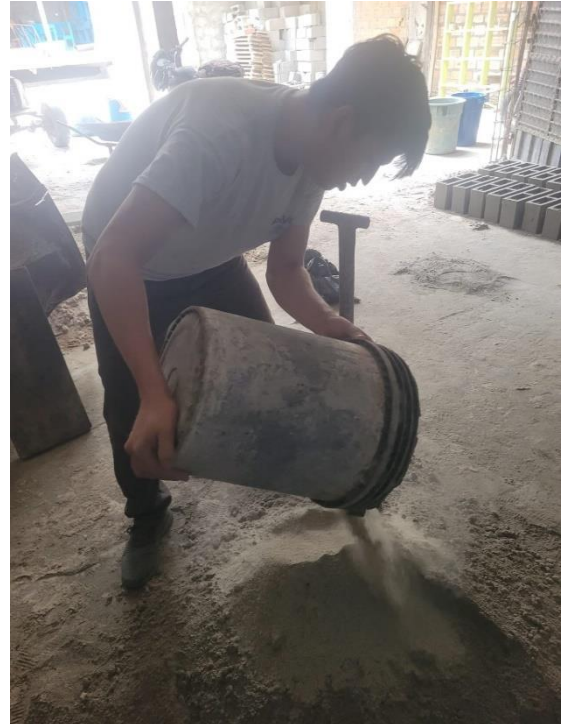
Foto N°22: Dosificación del cemento y PET para la mezcla de las unidades de albañilería
