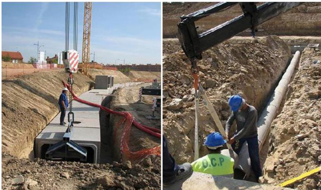
Figura N°13: Intercambiador tierra-aire en el Hemiciclo solar
