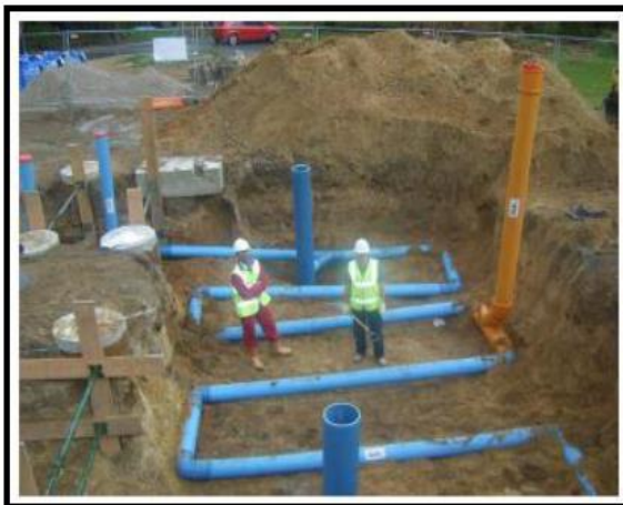
Figura N°8: Sistema de Tubos enterrados
