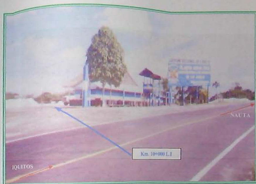
Foto N° 03.- Entrada principal de la planta de asfalto en donde se encuentra el laboratorio de asfalto (Km. 10+000 – Carretera Iquitos – Nauta)
