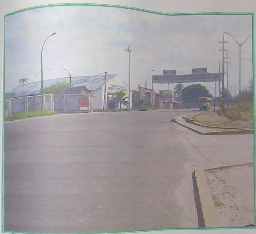
Foto N° 16.- Entrada a Iquitos por la Av. Abelardo Quiñones - Se aprecia un Pavimento Mixto (Concreto Hidráulico + Mortero Asfáltico). En este tramo el pavimento se encuentra en buena condición con Ligeras Fisuras Distrito de San Juan
