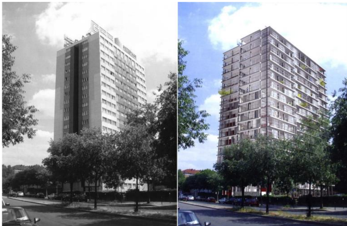
Figura N° 19: Izquierda: primer diseño ejecutado. Derecha: rehabilitación del edificio. Fuente: Lacaton y Vassal
