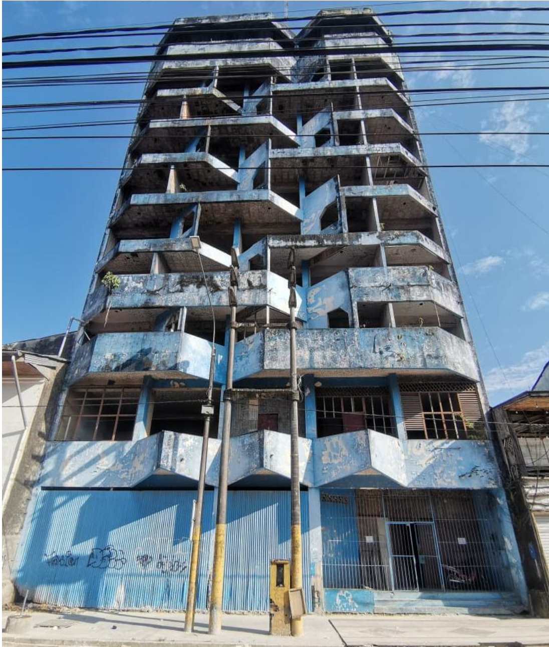
Figura N° 03: Edificio de EsSalud, estado actual (año 2023).
