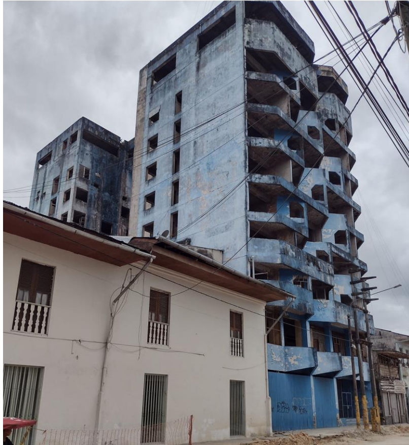
Figura N° 16: Edificio abandonado “Rio Amazonas” de propiedad de EsSalud. Fuente: Google imágenes
