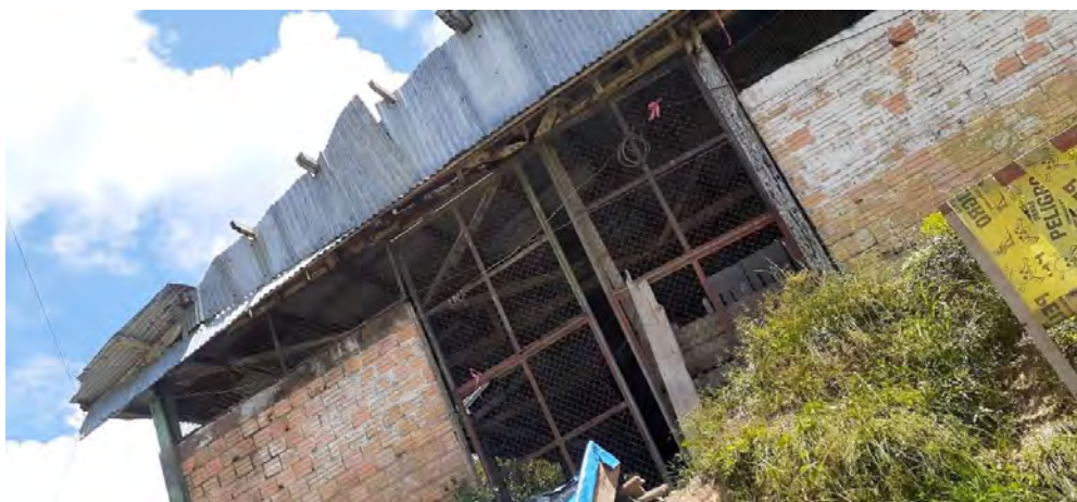
Lamina 52: Vista estado actual de la edificación existente
