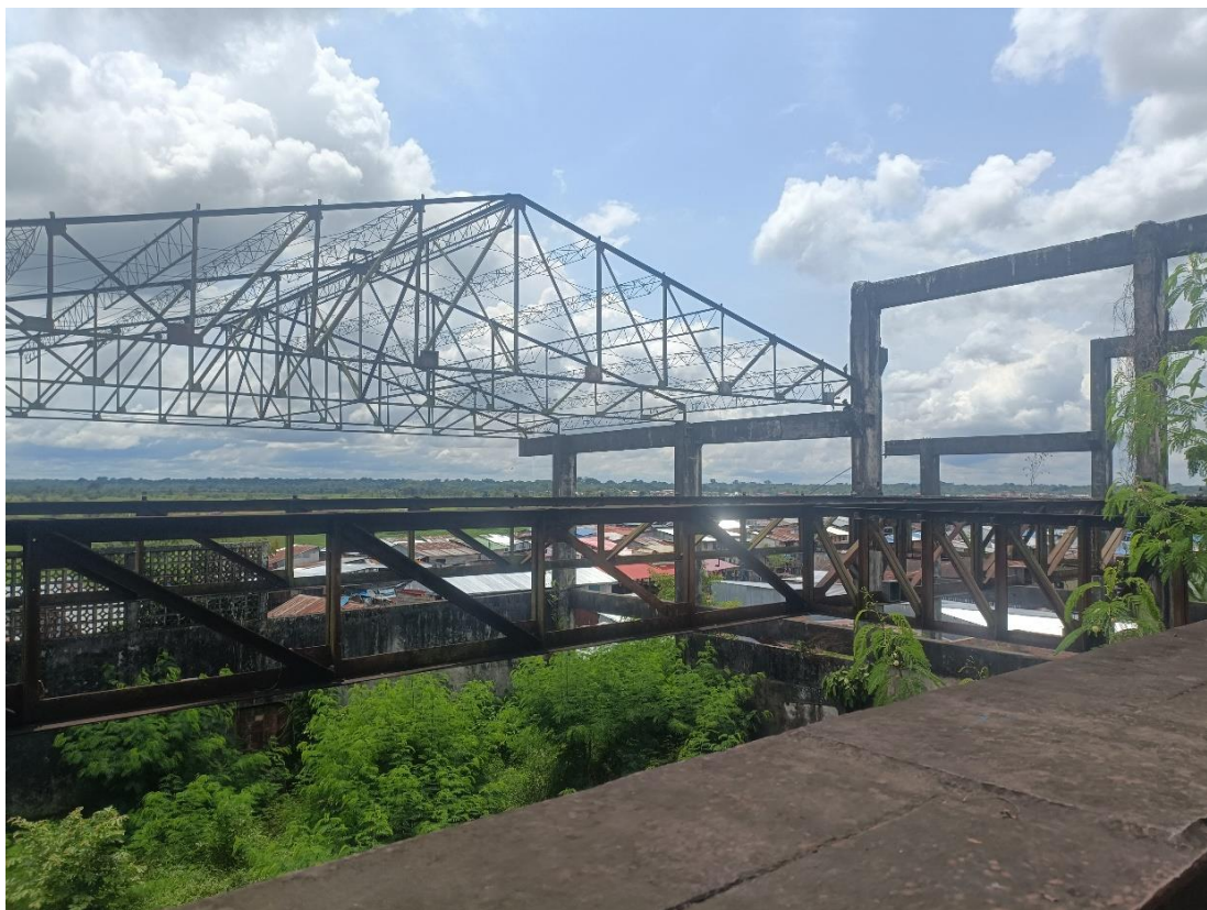
Vista panorámica de la estructura
