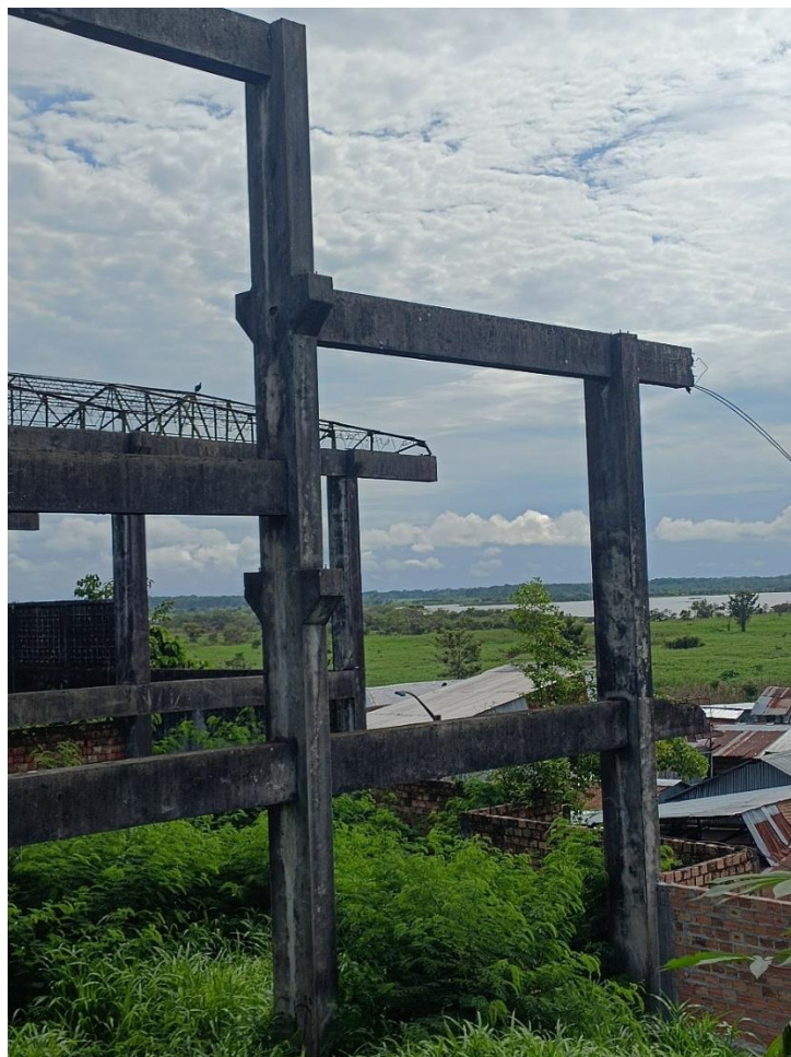
Vista panorámica de la estructura
