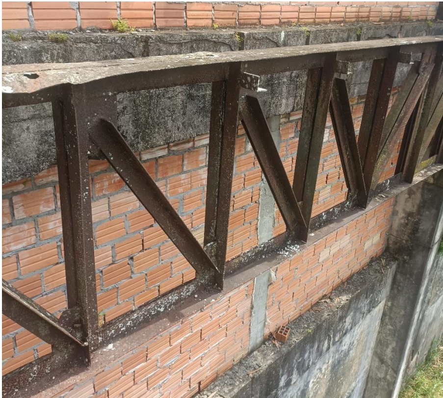
Vista de la armadura metálica frontal de la estructura en estado de corrosión
