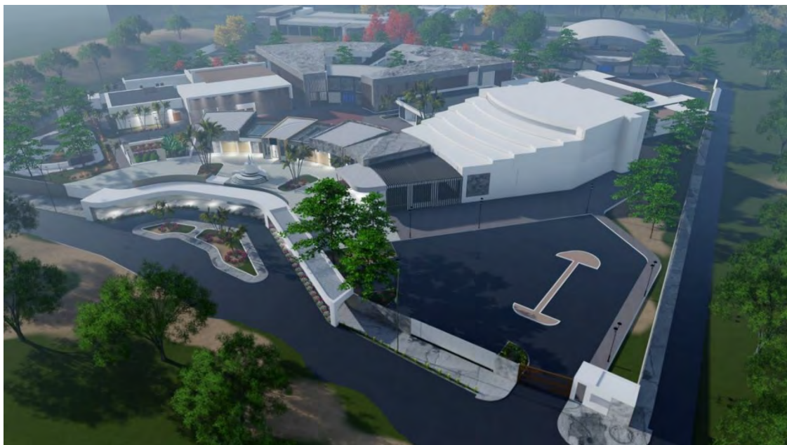
VISTA DEL INGRESO AL ESTACIONAMIENTO
