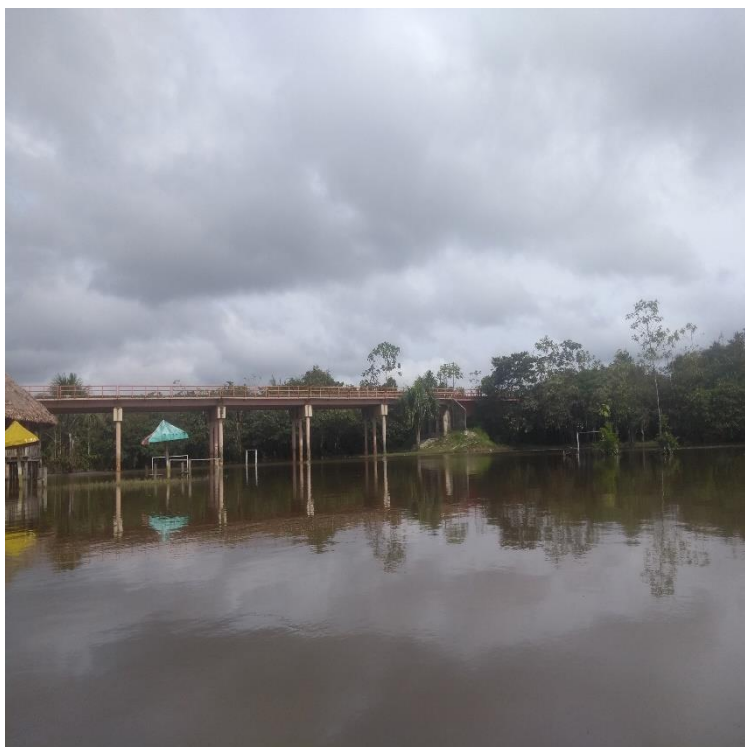
Figura N° 17. Puente Itaya, carretera Iquitos – Nauta, Km 57.
