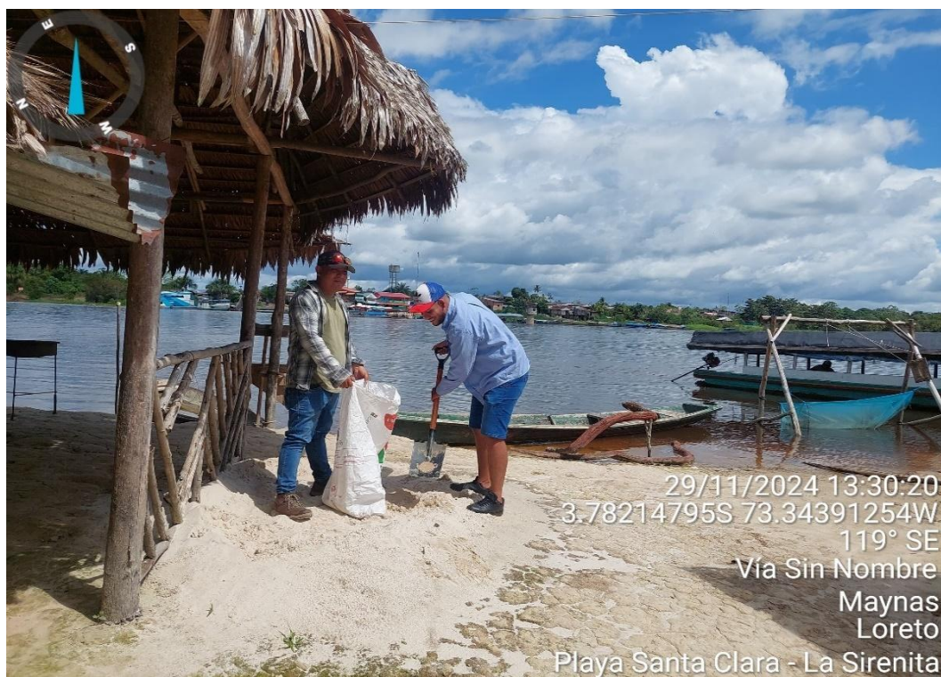
Imagen 3: Recolección del agregado fino (arena del Rio Nanay).
