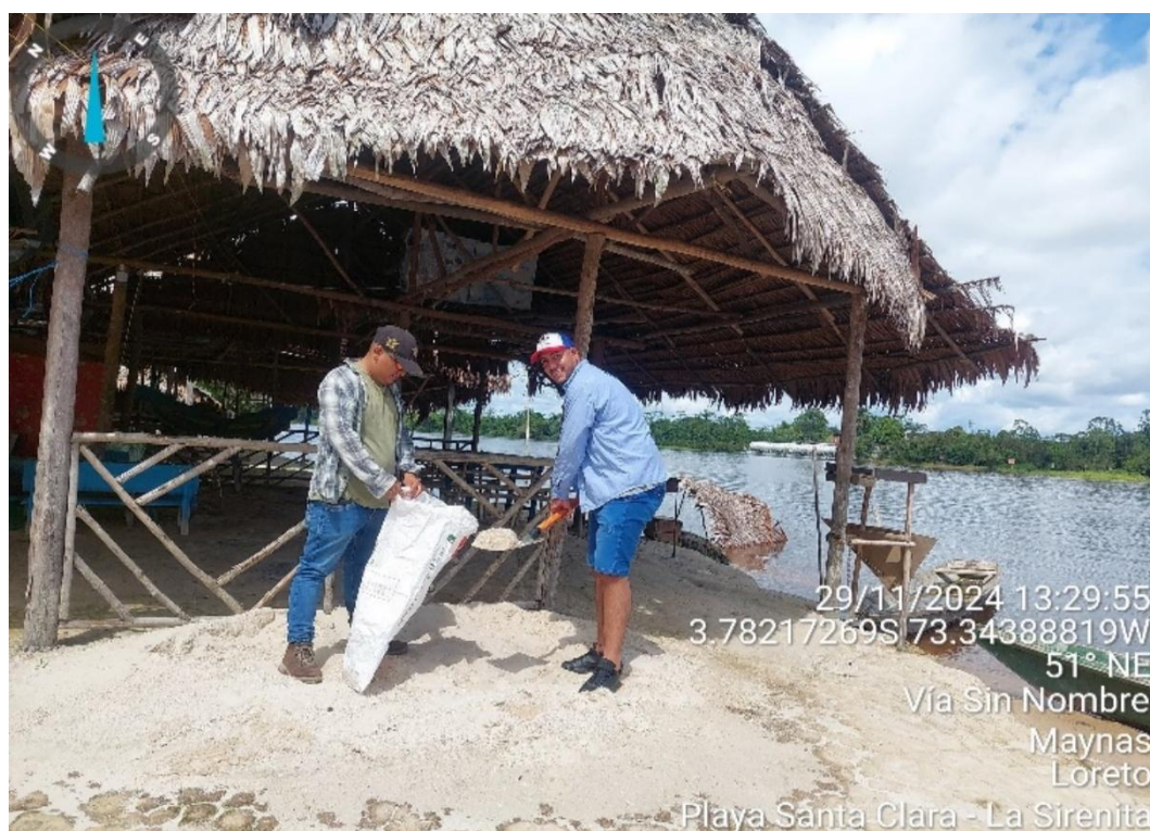
Imagen 2: Recolección del agregado fino (arena del Rio Nanay).
