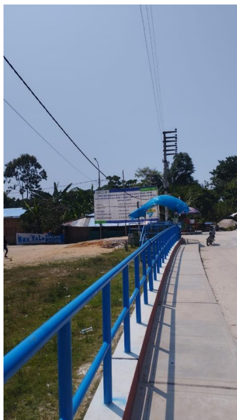
Figura 101: Marco contextual, tramo final hacia el río Itaya de la Carretera Cabo Lopez
