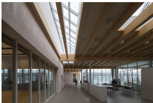
Figura 91: Caso Análogo 3, vista de los sobretechos para la iluminación
