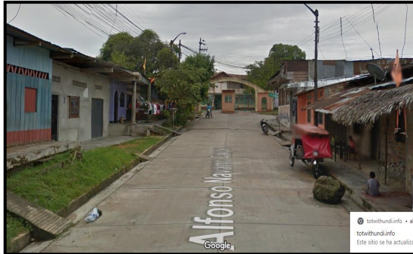
Figura 33. Fachada Principal de la Facultad de Medicina – con sus viviendas colindantes
