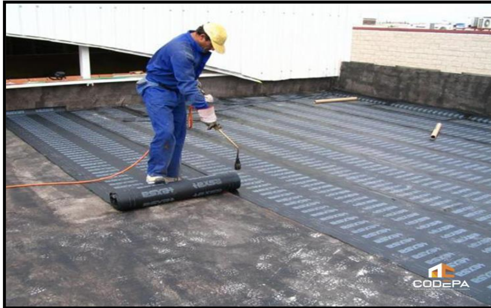
Figura 92. Recubrimiento de losa macizas con membrana asfáltica
