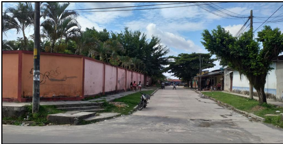
Figura 99. Muro Perimétrico – Fachada calle Ciro Alegría.
