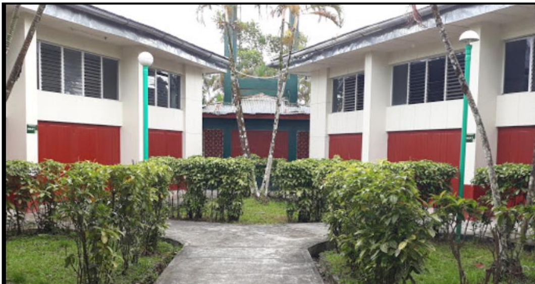
Figura 103. Módulo de aulas (Zonas Académicas)
