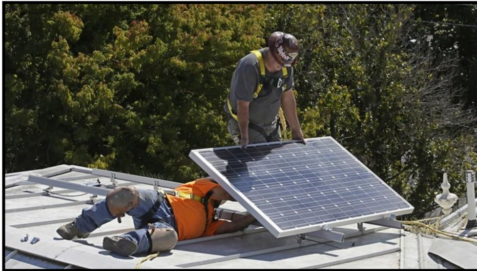
Figura 85. Instalación de Paneles Solares
