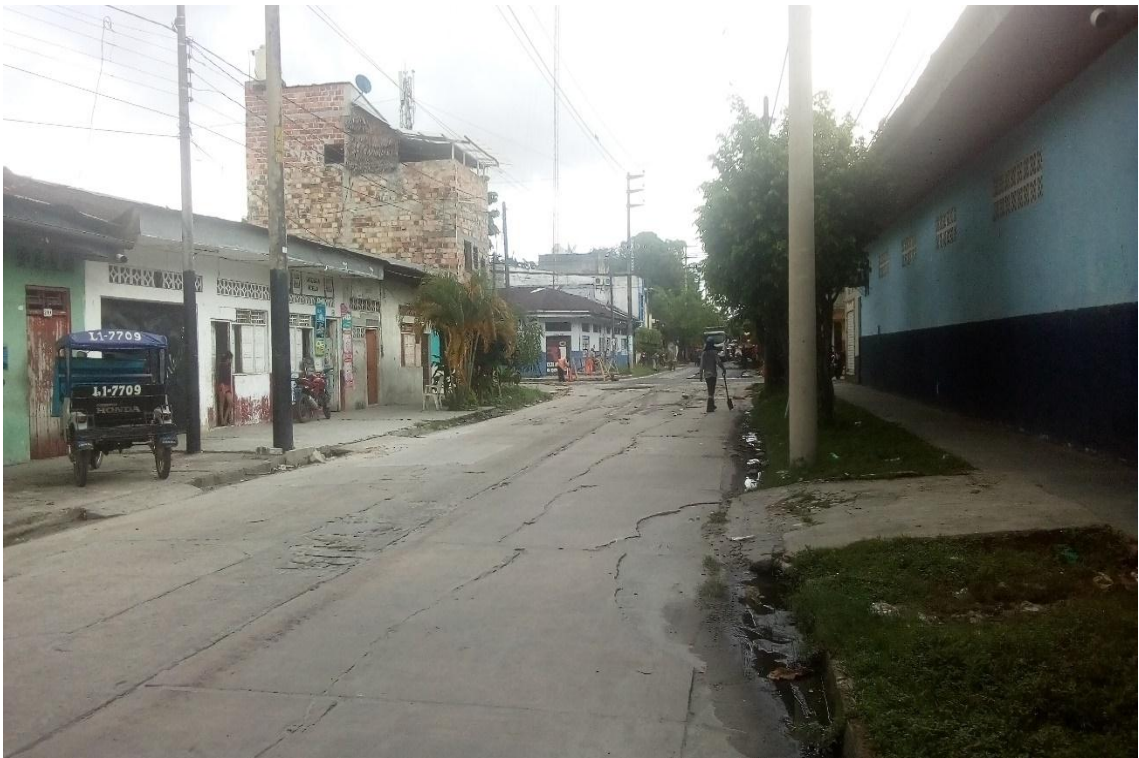
Jr. Fanning en proceso de ejecución.
