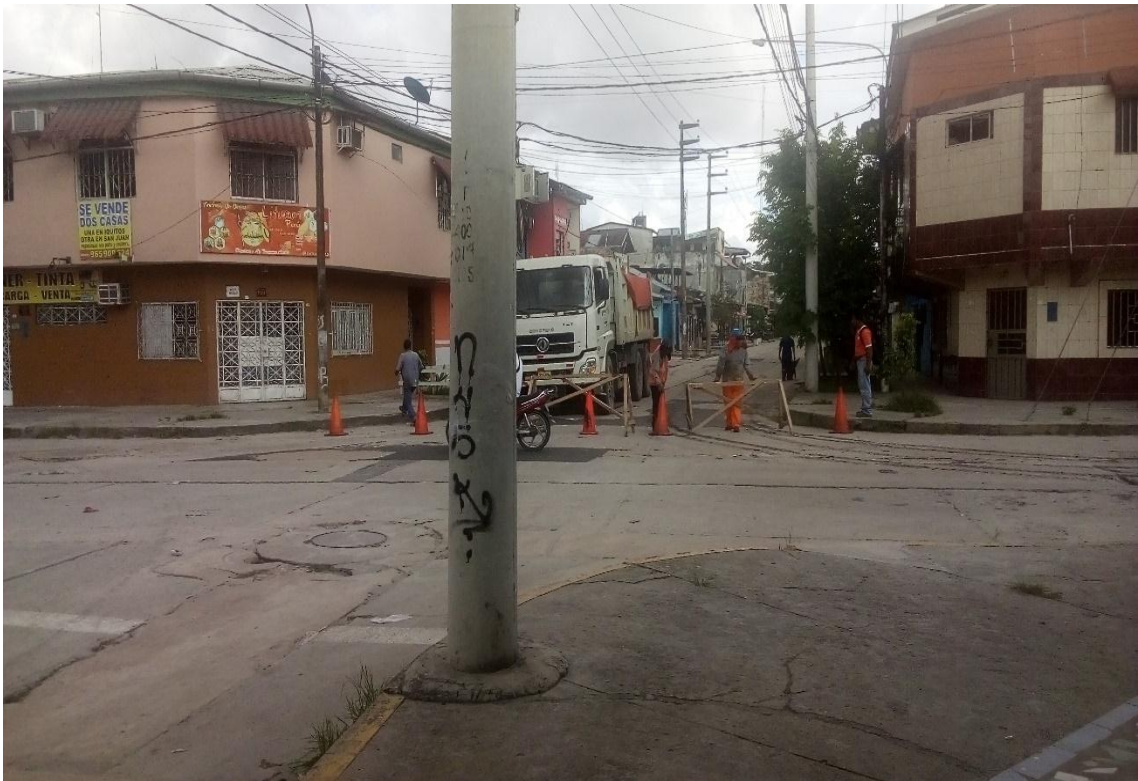
Trabajos de reasfaltado en Jr. Fanning
