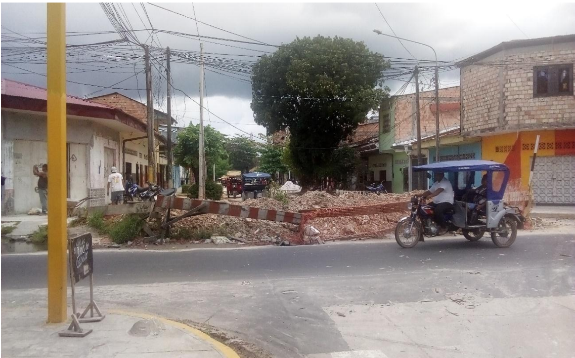
Jirón Sargento Lores (intersección con Castilla)
