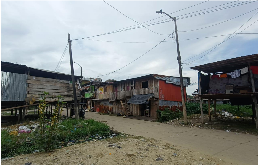
Imagen 3: visualización de viviendas precarias sin cumplir el RNE, con materiales deficientes, baja estabilidad estructural y falta de servicios básicos, evidenciando vulnerabilidad y riesgo frente a inundaciones.
