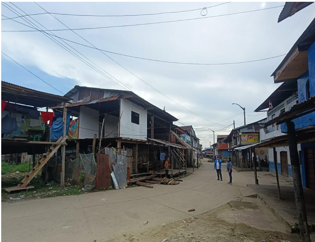
Imagen 4: Verificación del estado de las viviendas en las cuales se hizo el estudio.
