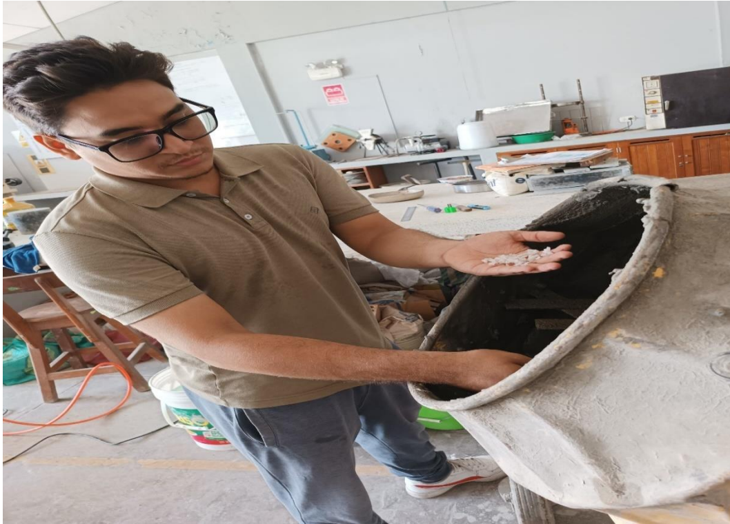
Imagen 3: Adición de plástico reciclado a la mezcla de concreto cemento – arena).
