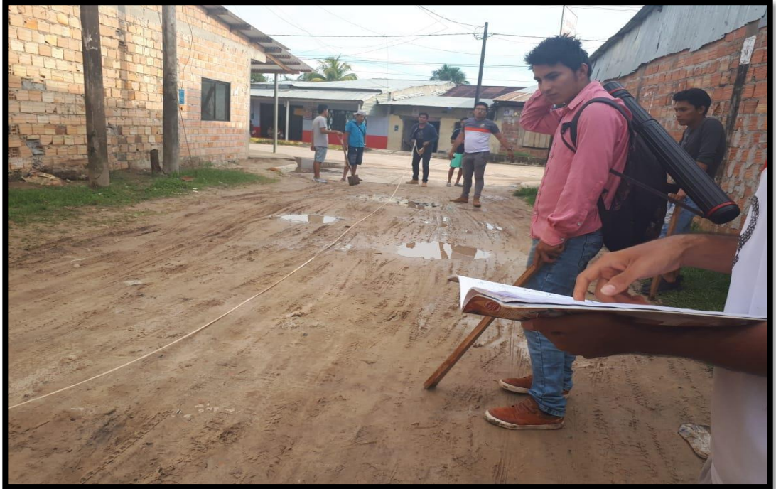
FOTO N° 20 UBICACIONES DE LAS CALICATAS PARA EL ESTUDIO DE SUELOS
