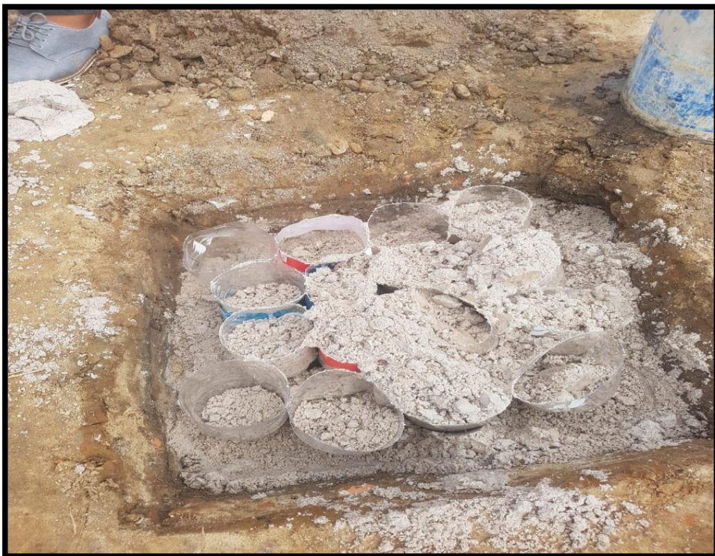
FOTO N° 26 COLOCACION DE LA ARENA
