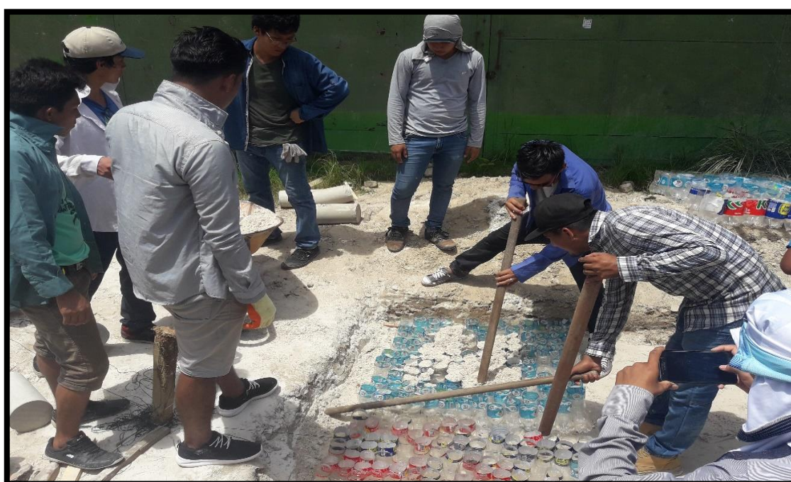
FOTO N° 37 LLENADO DE ARENA A LAS BOTELLAS Y COMPACTADAS
