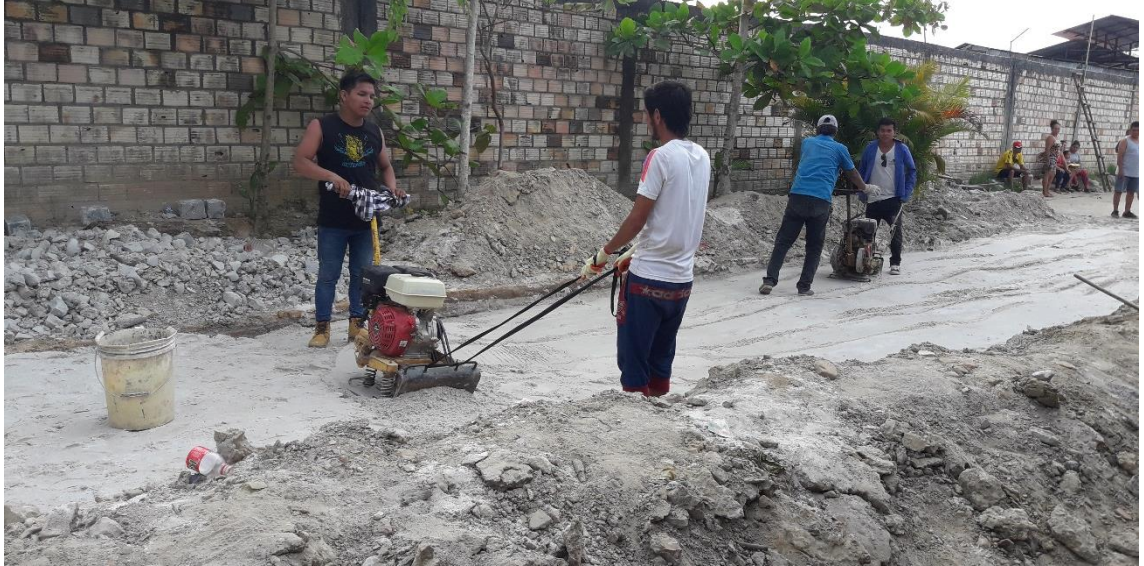
FOTO N° 9 Compactación con plancha compactadora
