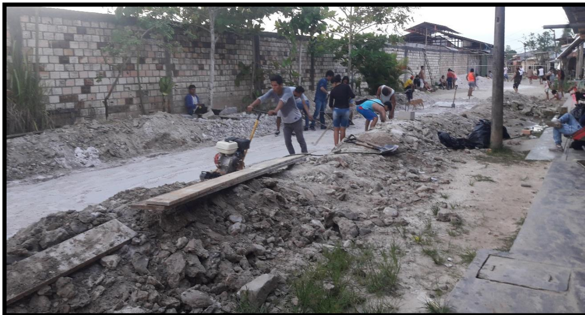
FOTO N° 40 COMPACTACIÓN CON PLANCHA DE COMPACTADORA
