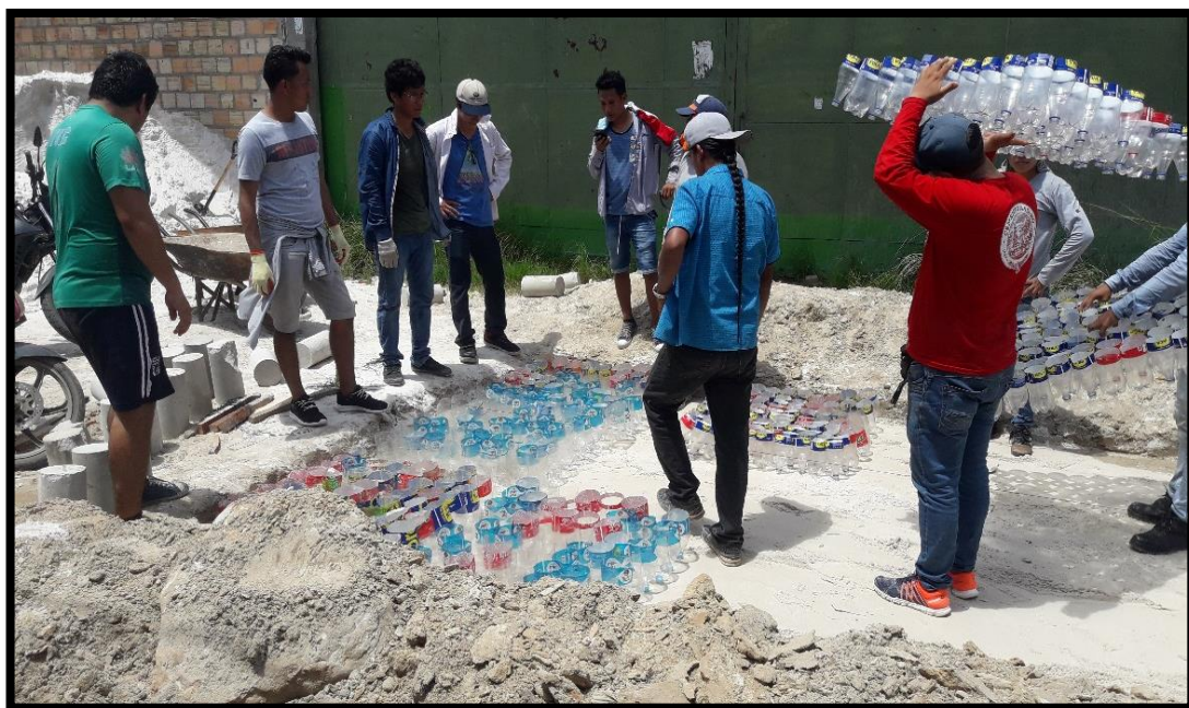
FOTO N° 36 CAMA DE ARENA Y TENDIDO DE LAS BOTELLAS PLÁSTICAS
