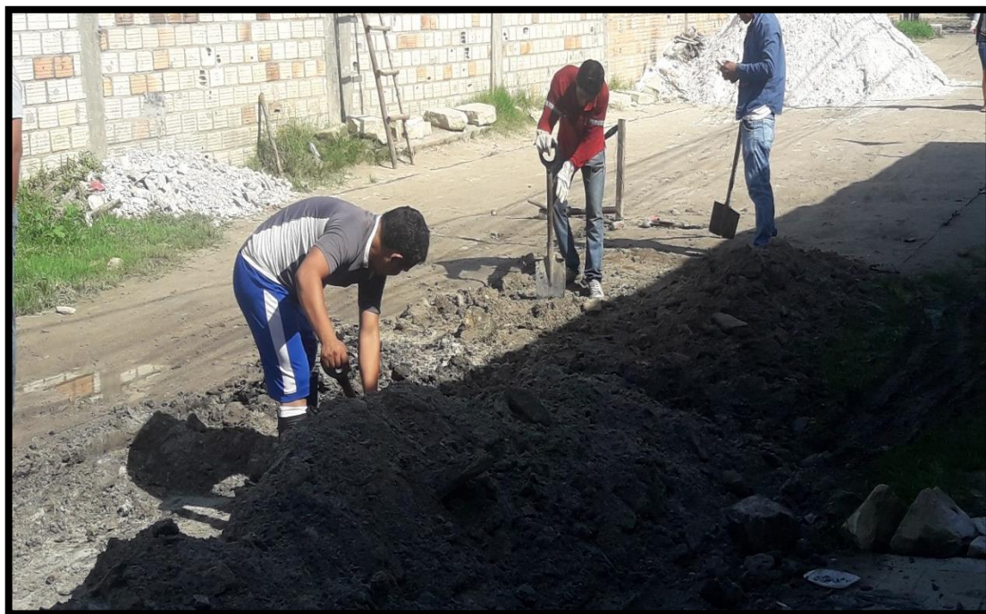
FOTO N° 34 EXCAVACIÓN PROFUNDIDAD 25 cm
