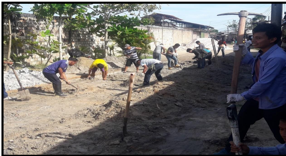
FOTO N° 32 EJECUCION DEL PROYECTO
