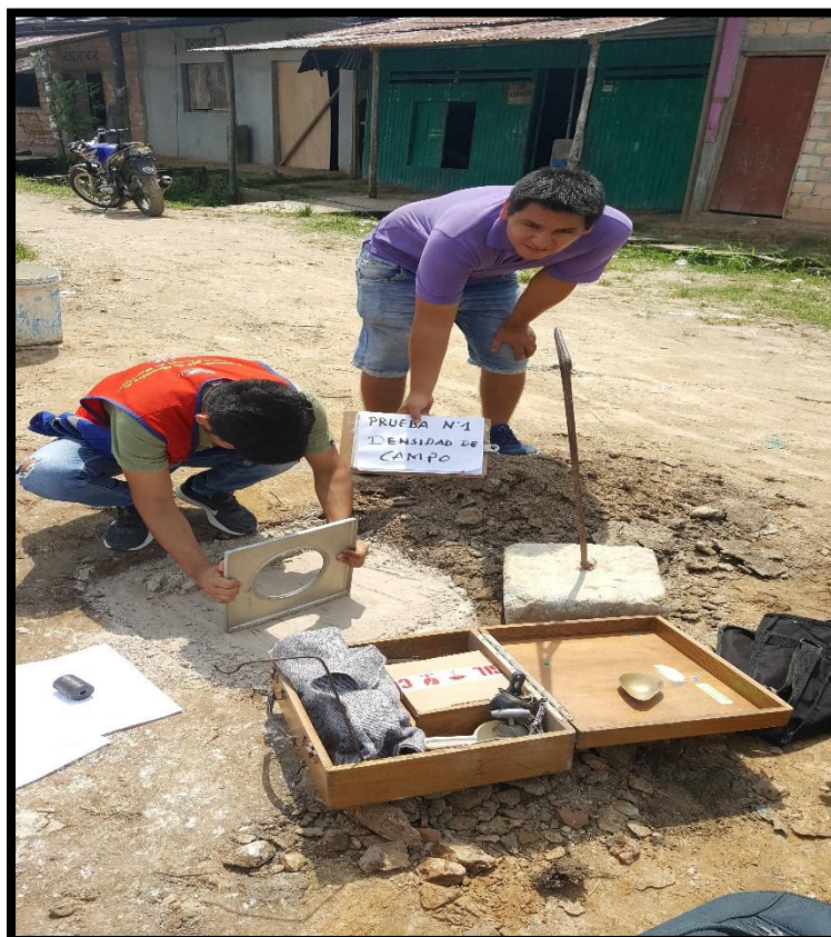
FOTO N° 28 PRUEBA DENSIDAD DE CAMPO
