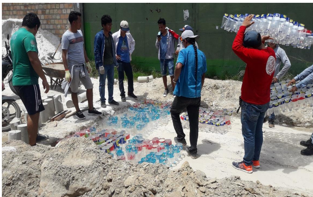
FOTO N° 4 Colocacion de paneles
