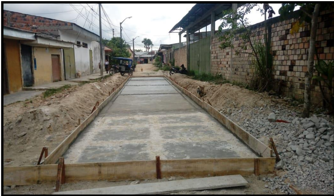
FOTO N° 42 VACEADO DE CONCRETO f_c' 210 kg/cm 2 acabado
