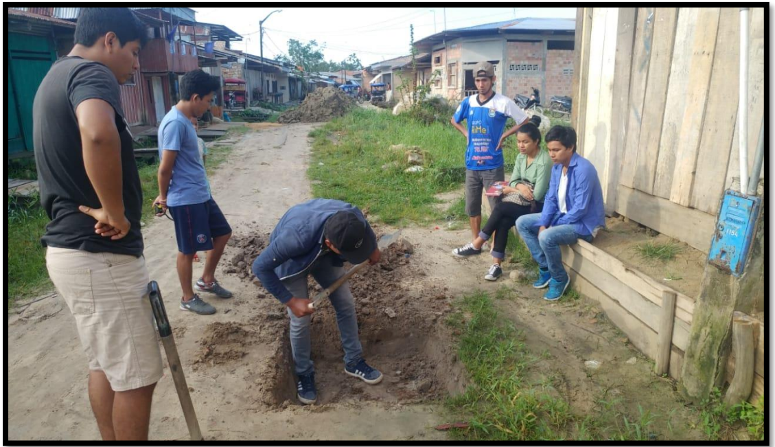
FOTO N° 22 EXCAVACION DE CALICATAS
