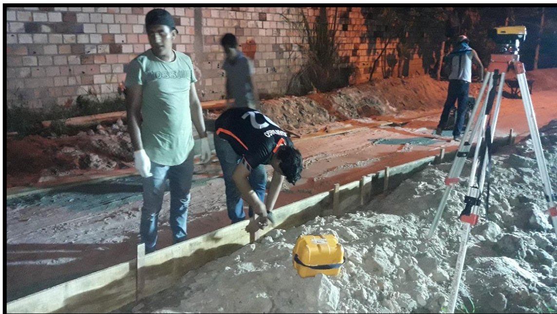
FOTO N° 41 ENCOFRADO Y NIVELACIÓN
