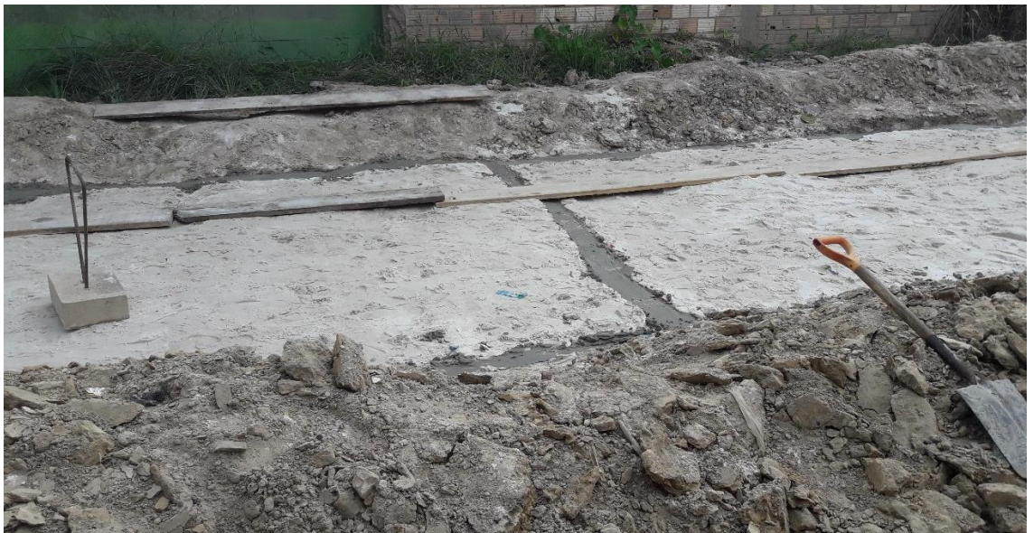
FOTO N° 8 Apisonado de todo el sistema
