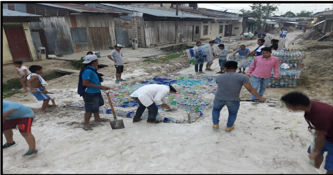
FOTO N° 39 TENDIDO DE LAS BOTELLAS PLÁSTICAS
