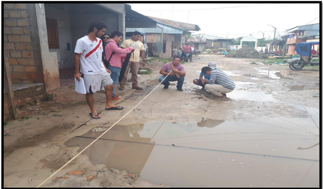
FOTO N° 21 DISTANCIA DE LAS CALICATAS
