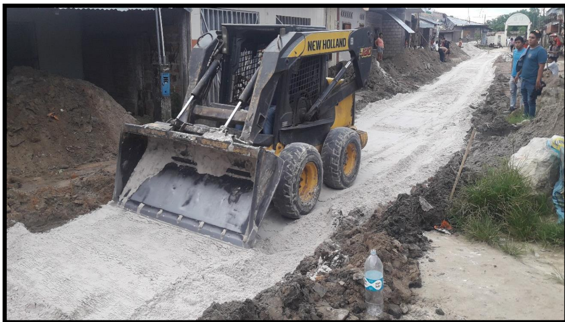
FOTO N° 33 CAMA DE ARENA
