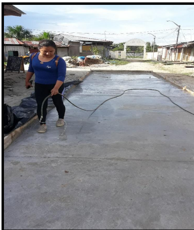
FOTO N° 43 CURADO DEL MORTERO
