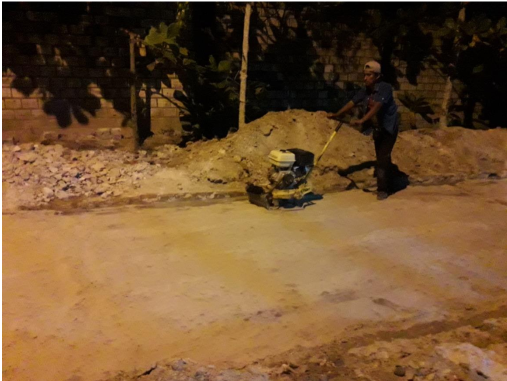
FOTO N° 10 Compactación de toda el area de influencia del proyecto
