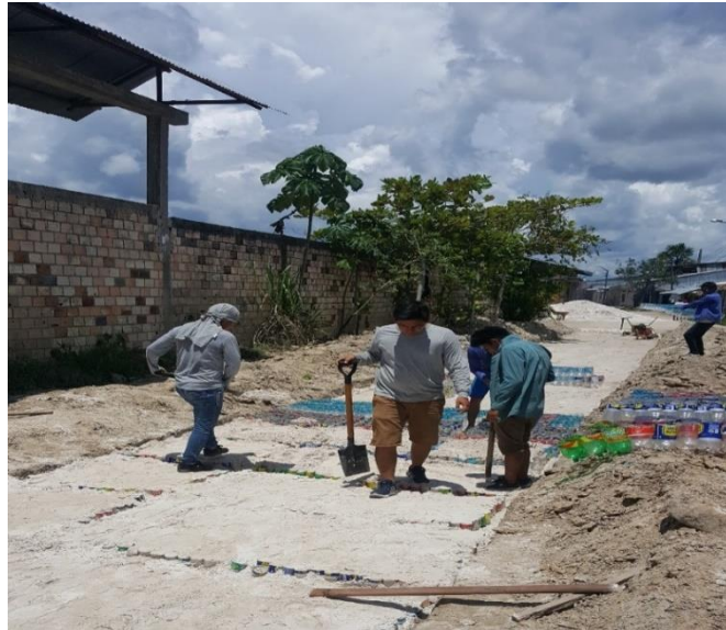
FOTO N° 15 Rellenado y compactado
