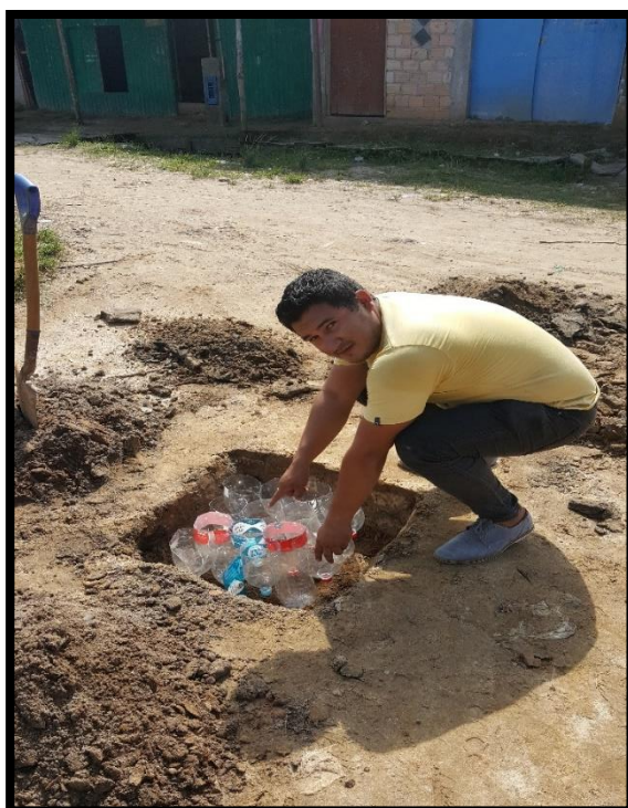
FOTO N° 25 COLOCACION DE LAS BOTELLAS PLASTICAS
