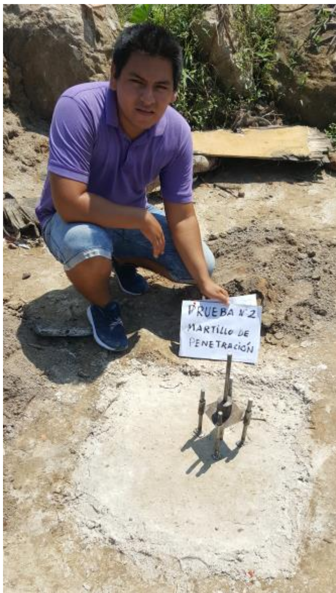
FOTO N° 13 Prueba con el minimartillo de dinaica ligera
