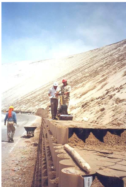
IMAGEN N° 2 Aplicación de GEOCELDAS en Cerro de Arena
