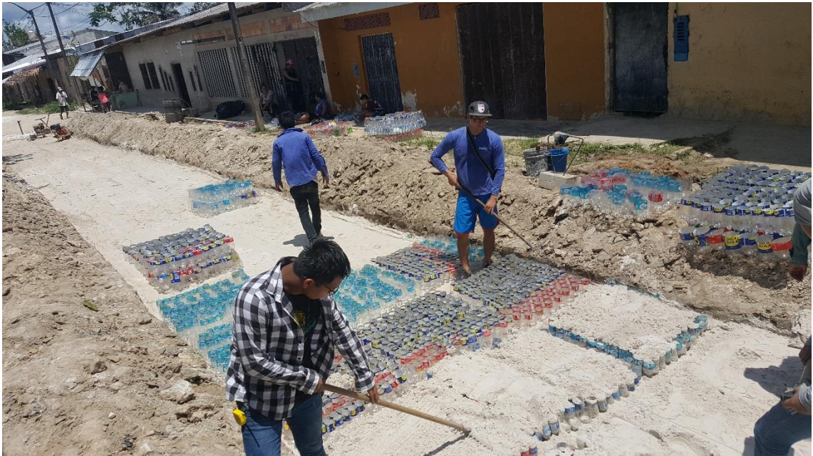
FOTO N° 5 Rellenado con arena
