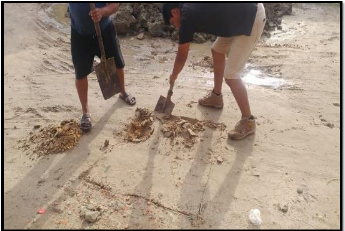
FOTO N° 23 TRAZADO DE CALICATAS
