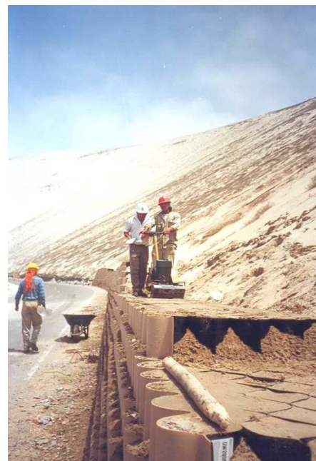
IMAGEN N° 2 Aplicación de GEOCELDAS en Cerro de Arena
