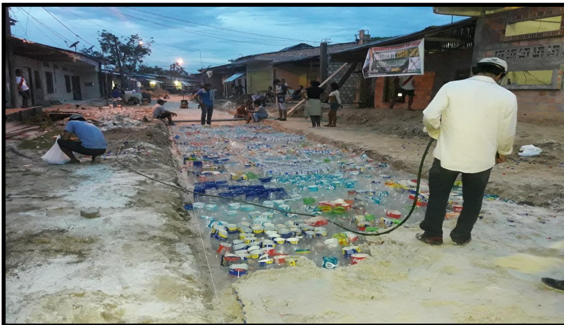
FOTO N° 38 TENDIDO DE LAS BOTELLAS PLÁSTICAS
