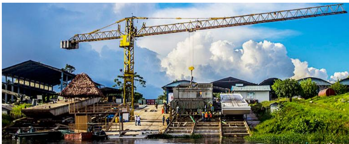
Figura N° 2: Vista varaderos 1 y 2 de SIMA IQUITOS, 2017
