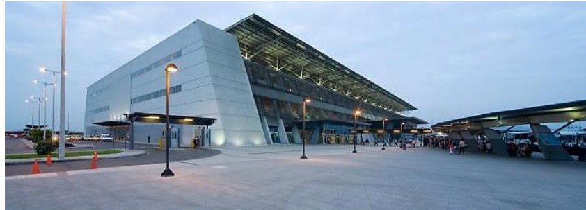
Imagen 30: Terminal Terrestre de Guayaquil
