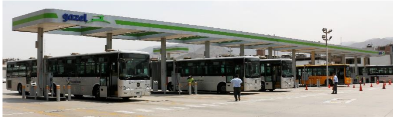
Imagen 20: Estación de Combustible Fuente de Imagen: (Lima, 2010)
