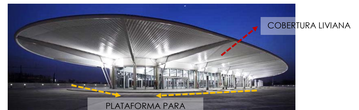
Imagen 37: Zona de Embarque y Desembarque de Pasajeros, Planta Alta de Terminal de Ómnibus de Santiago del Estero Fuente de Imagen: (ARQA PERU, 2008) Elaboración: Propia
