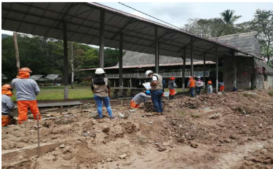
FOTO N.º01: ENCOFRADO DE CUNETAS EN EL JR. HUALLAGA CUADRA 10
