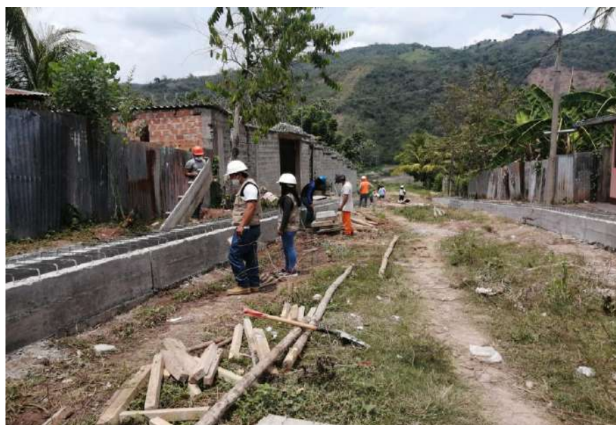
FOTO N.º02: DESENCOFRADO DE CUNETAS EN EL JR. SAN JUAN CCUADRA 2
