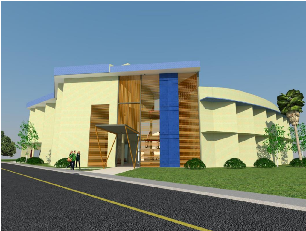
Vista de la Fachada Principal
