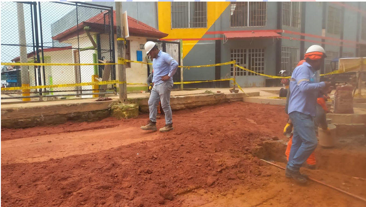
FIGURA 25: VERIFICACION DE TRABAJOS
