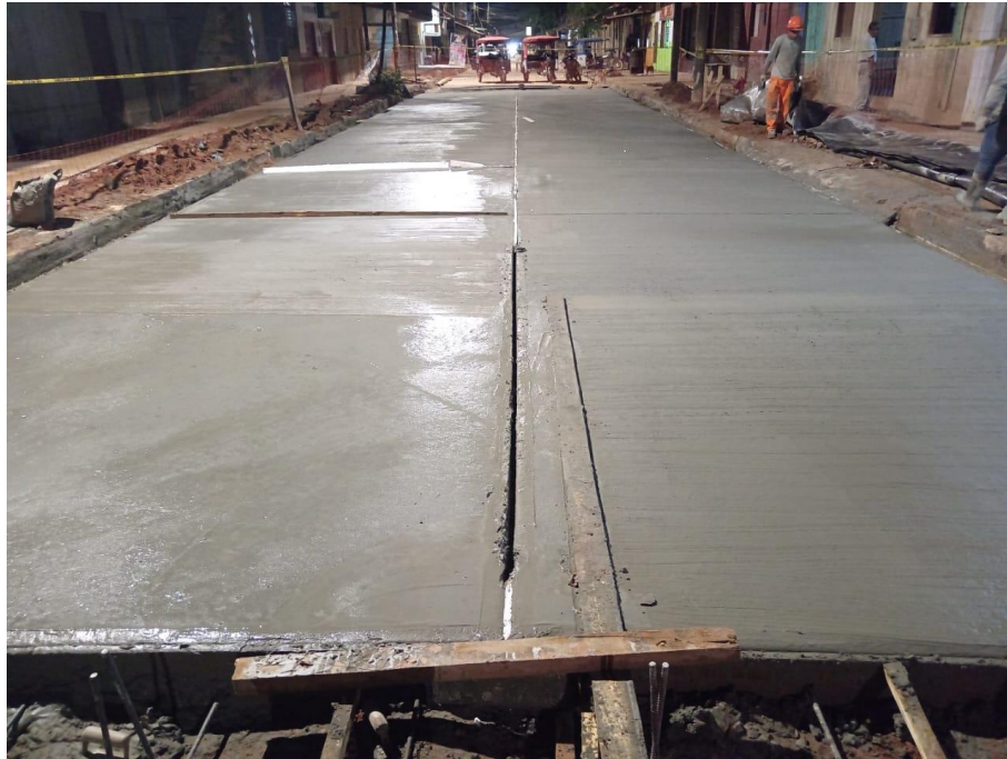
FIGURA 24: VACEADO DE LOSA DE RODADURA
