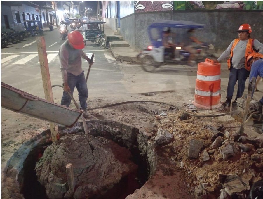
FIGURA 22: VACEADO DE BUZON CON MIXER
