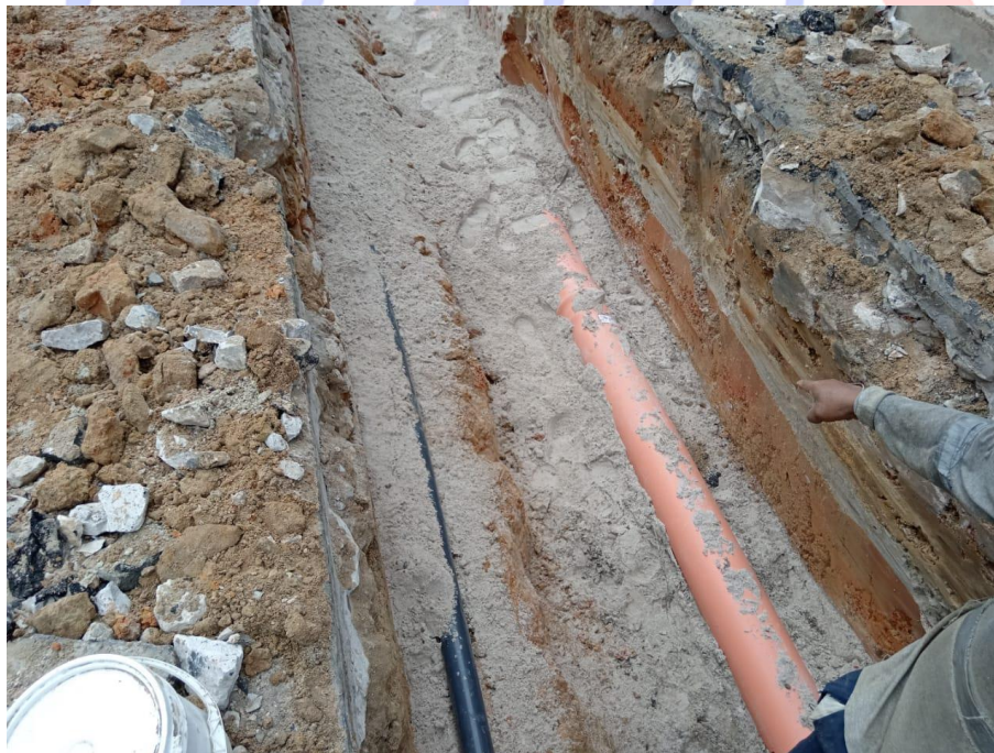
FIGURA 23: TENDIDO DE TUBERIA
