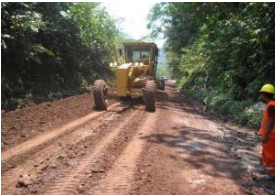
Foto N° 16. Mezclado Aditivo Sólido.
