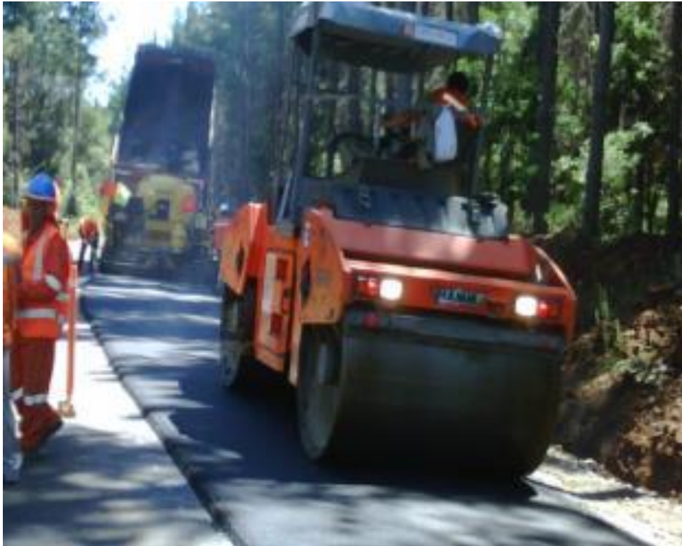
Foto N° 26. Colocación Mezcla Asfáltica
