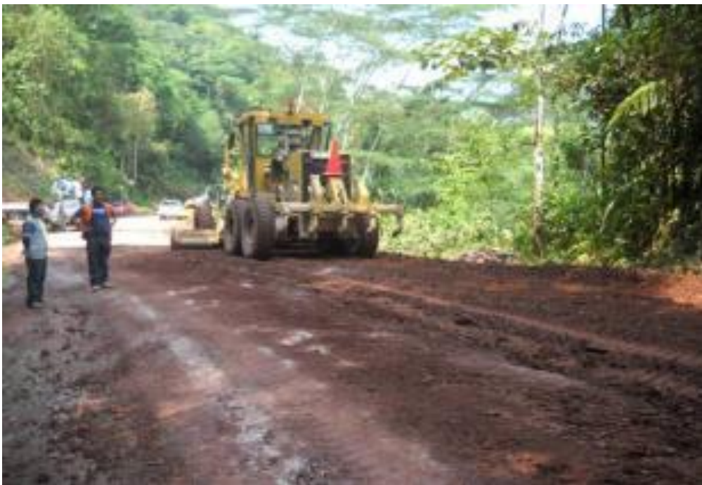
Foto N° 13. Esparcido del Material
