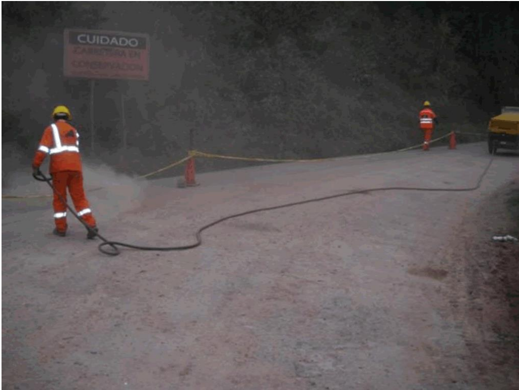
Foto N° 22. Barrido y Soplado Base
