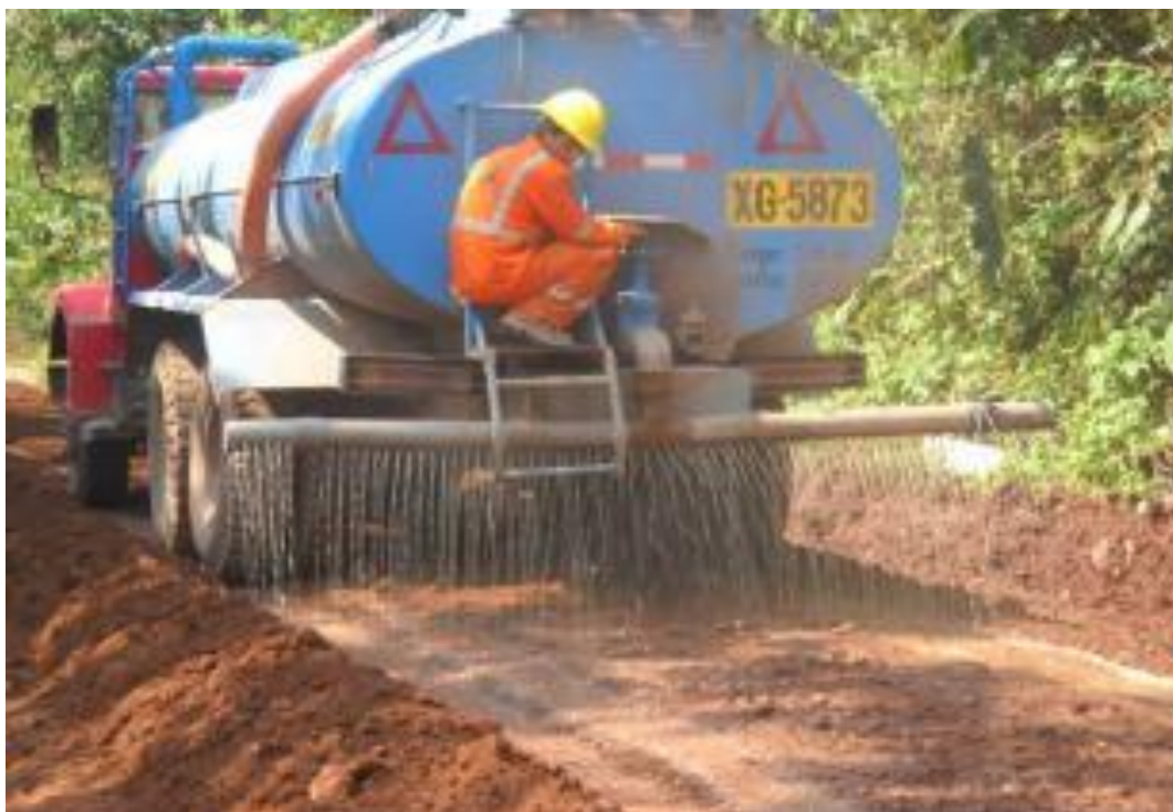
Foto N° 17. Adición Aditivo Líquido Proes100
