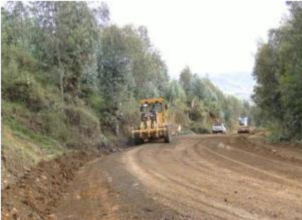
Foto N° 12. Preparación de la Subrasante
