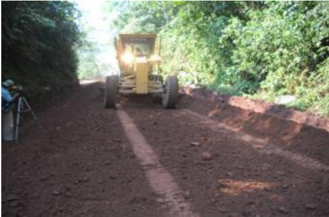
Foto N° 18. Mezclando Aditivo Líquido
