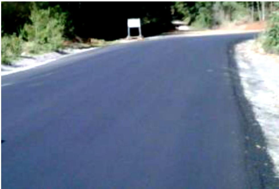
Foto N° 27. Base Proes con Mezcla Asfalto en Caliente, Espesor 4,0 cm.
