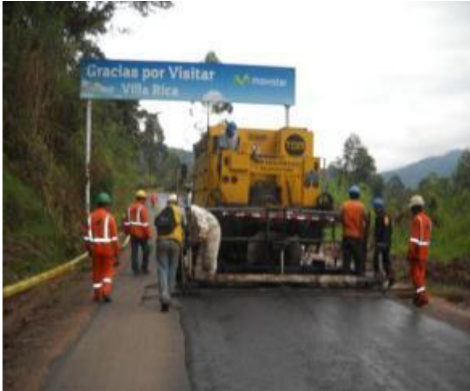
Foto N° 24. Lechada Asfáltica.
