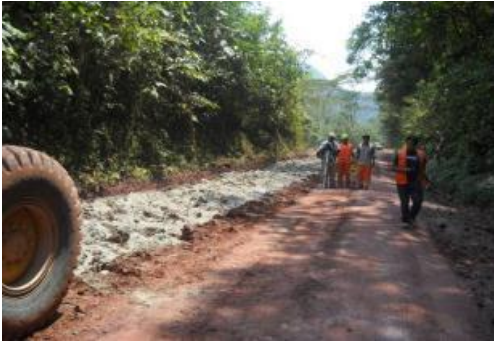
Foto N° 14. Aplicación Aditivo Sólido.
