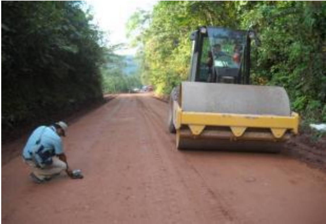
Foto N° 20. Compactación con Niveladora
