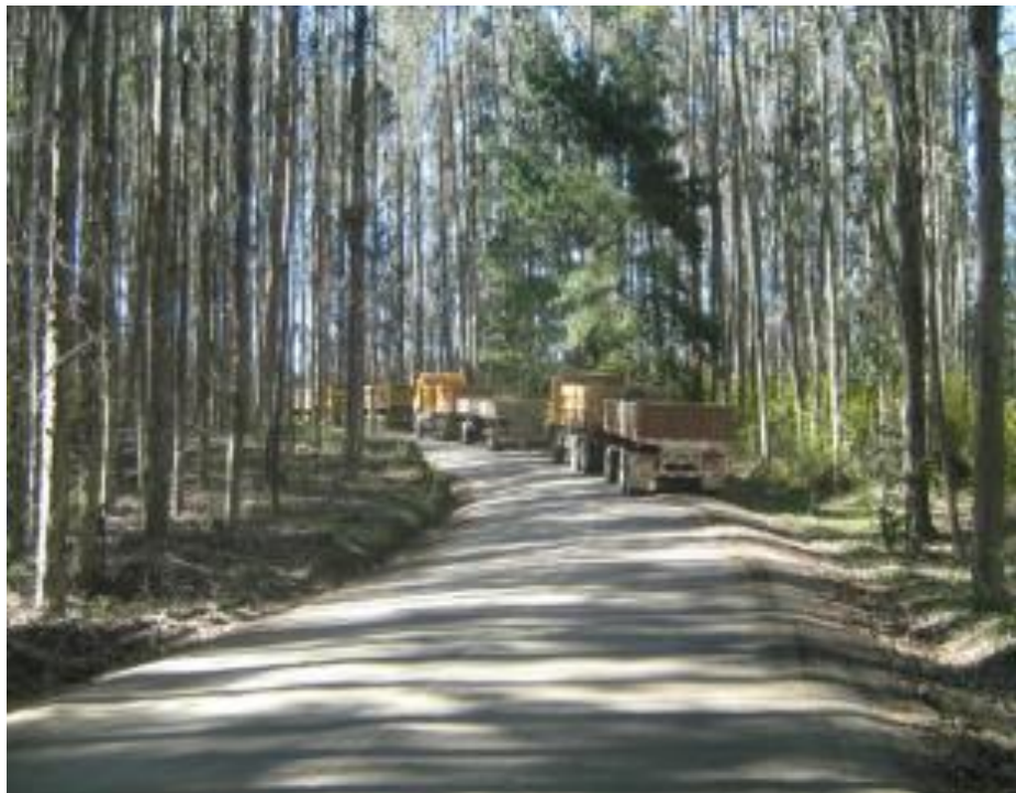
Foto N° 25. Base Proes con Tratamiento Asfáltico (Slurry)
