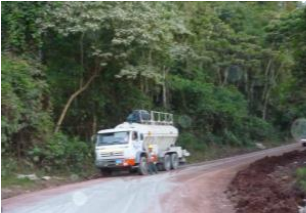
Foto N° 15. Con Camión Esparcidor
