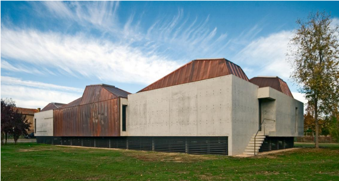
Gráfico N° 14: Centro de Investigación e Interpretación Ríos Órbigo, Tera y Esla. Vista lateral izquierda
