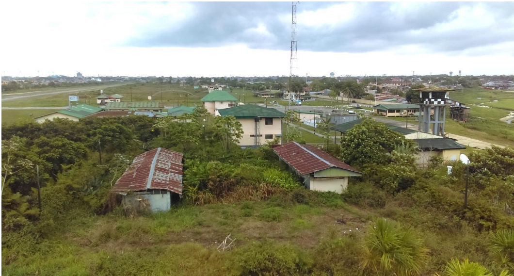
Gráfico N° 34: Vista aérea del lugar del emplazamiento mostrando la topografía
