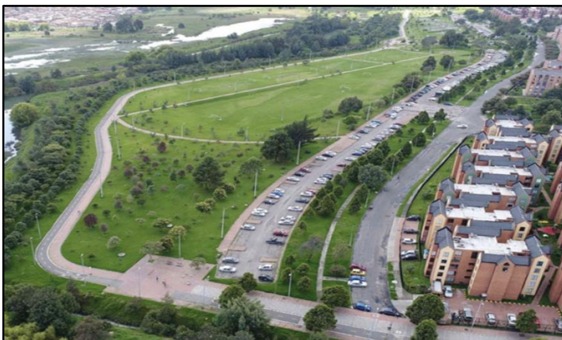
IMAGEN N°20: VISTA AEREA DE RECORRIDO DEL PARQUE POLIDEPORTIVO JUAN AMARILLO
